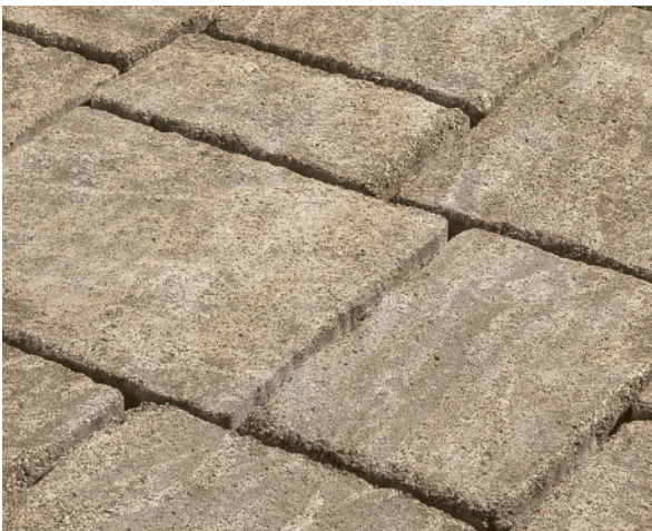
Fig.1 - Pavimentazione in autobloccante
