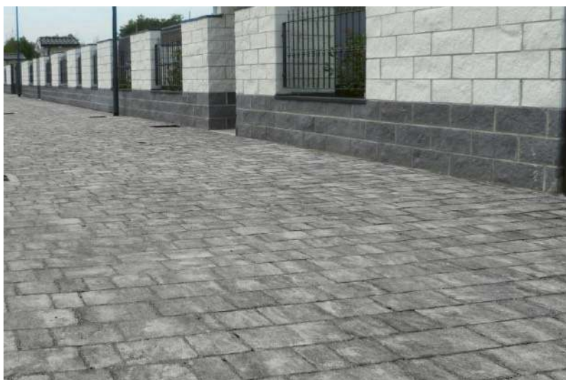
Fig.1 - massello autobloccante tipo - schema di posa
