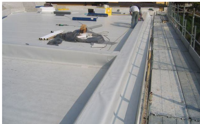
IMPERMEABILIZZAZIONE DELLA SOLETTA MEDIANTE GUAINA IN PVC
