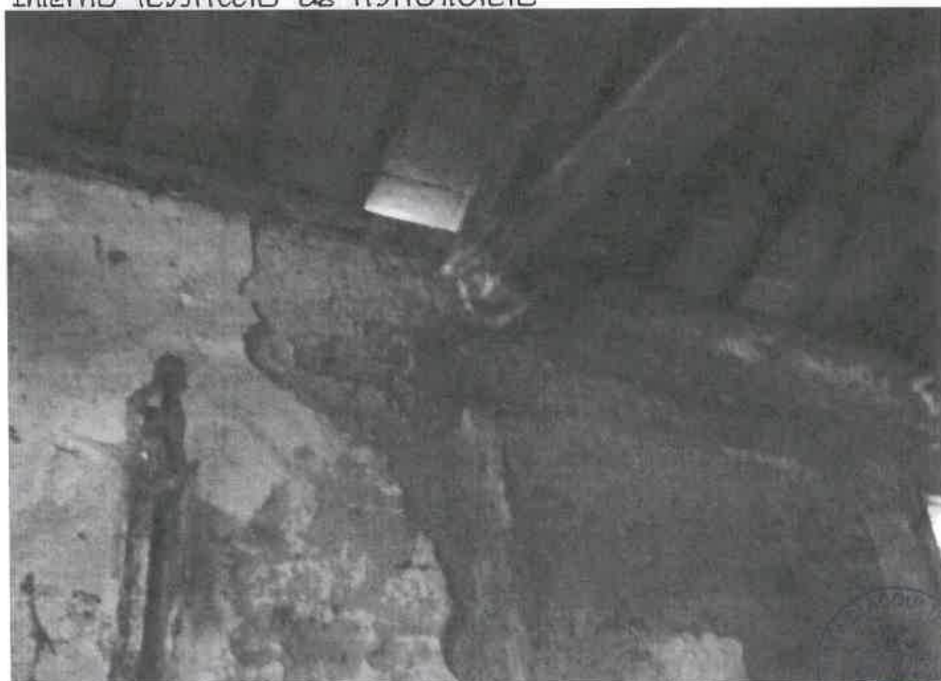
Interno fabbricato da ristrutturare. Acqui. Terme. 16.10.2015.
